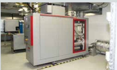
Das neue Sandvik 204 kW-BHKW
