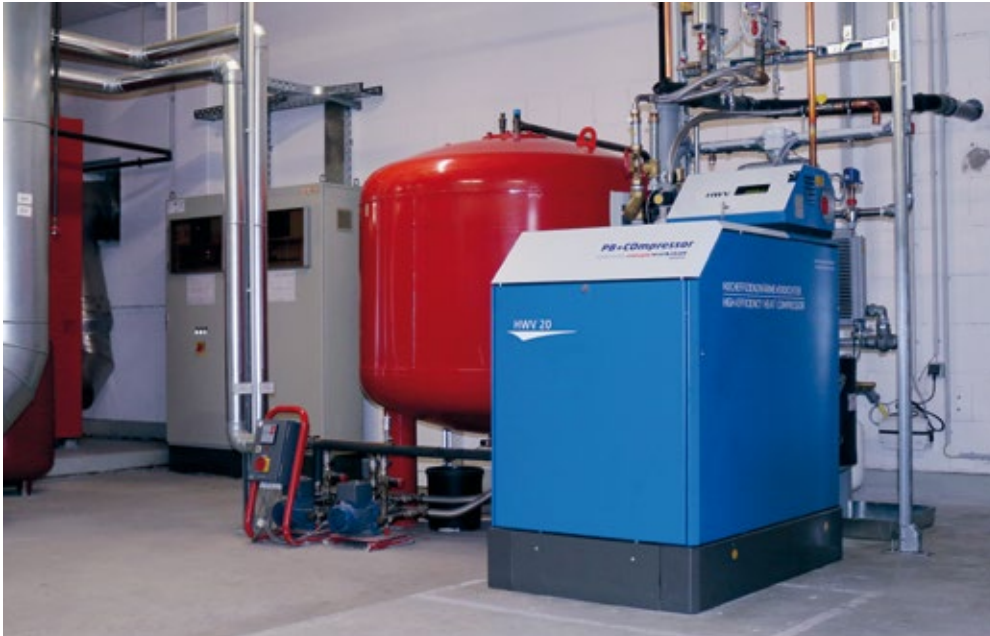
Hocheffizientes Druckluft-Wärme-Kraftwerk
