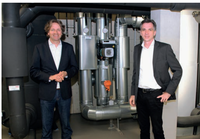
Geschäftsführer Dirk Langenströher und Adalbert Poray vor dem neuen Heizungsverteiler.
